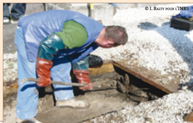
↑ Photo 6 : tentative pour soulever et tordre des ferrillages avec une barre à mine. Risque de blessure.
